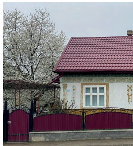
fig 56. Acoperișul și gardul au fost schimbate, în timp ce casa și detaliile sale au fost păstrate.
